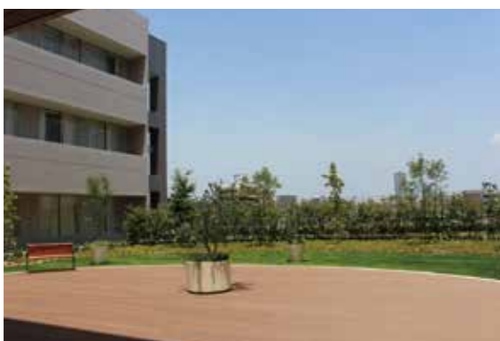
●新本館4階にある屋上庭園
