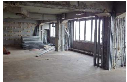
訓練の会場となる、解体工事中の旧本館
